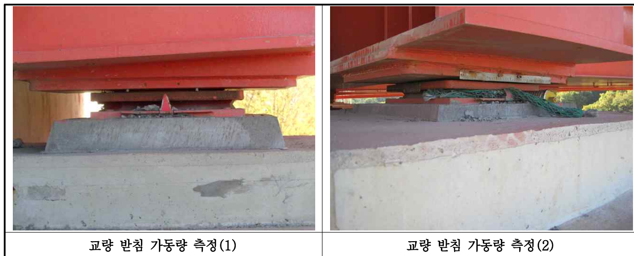
【사진 30.3.15】교량받침 이동량 측정
