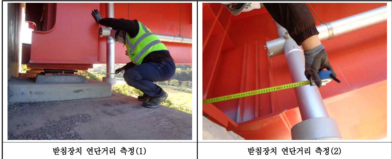
【사진 30.3.14】 교량받침장치 연단거리측정
