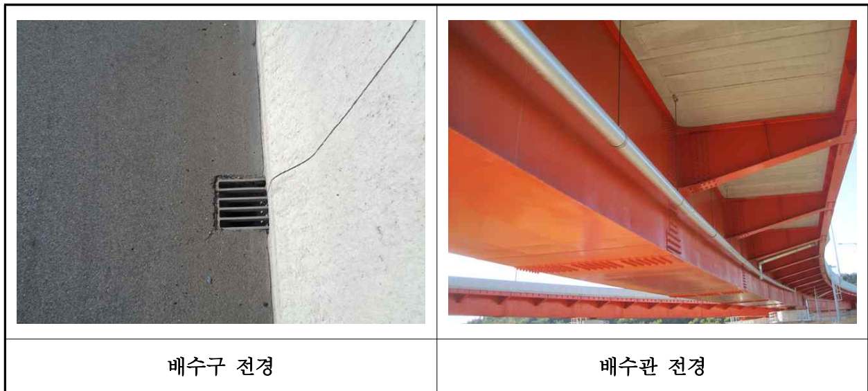
【사진 30.3.21】 배수시설 전경
