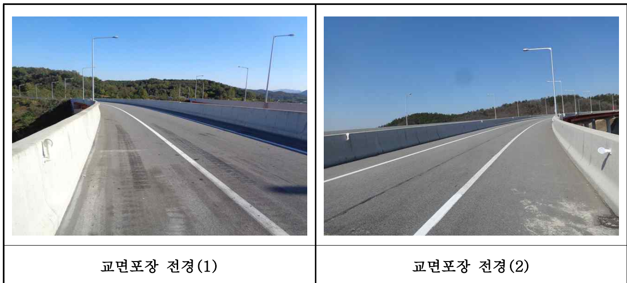
【사진 30.3.19】 교면포장 전경
