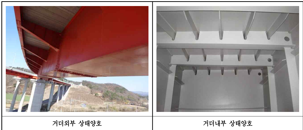
【사진 30.3.5】 거더 손상현황
