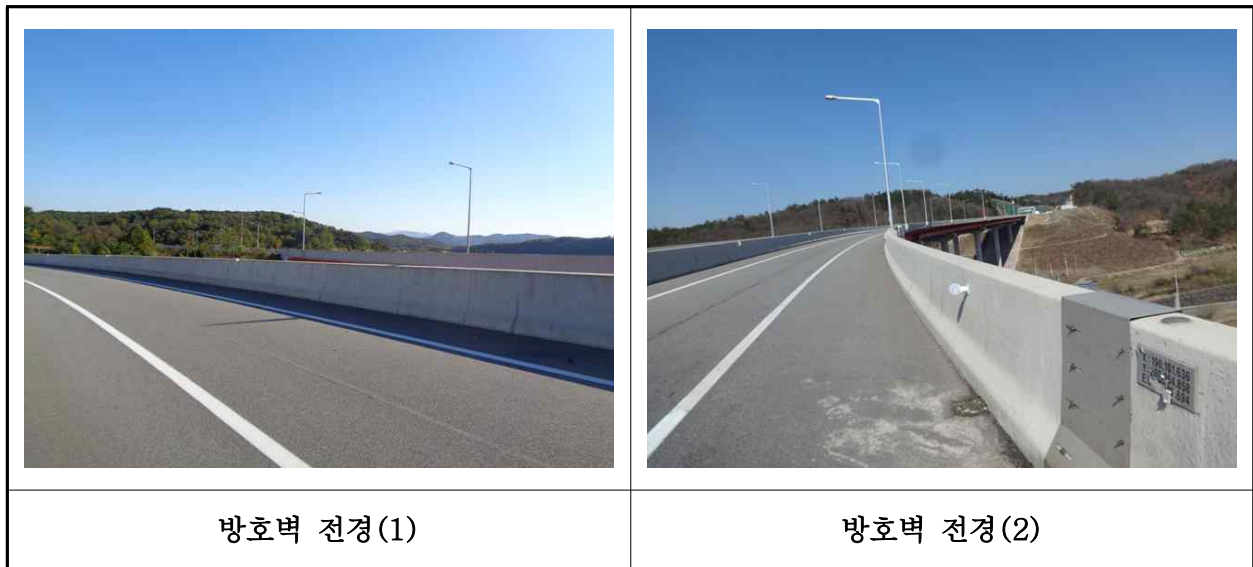
【사진 30.3.23】 방호벽 전경
