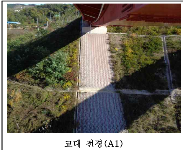
【사진 30.3.8】 교대 전경
