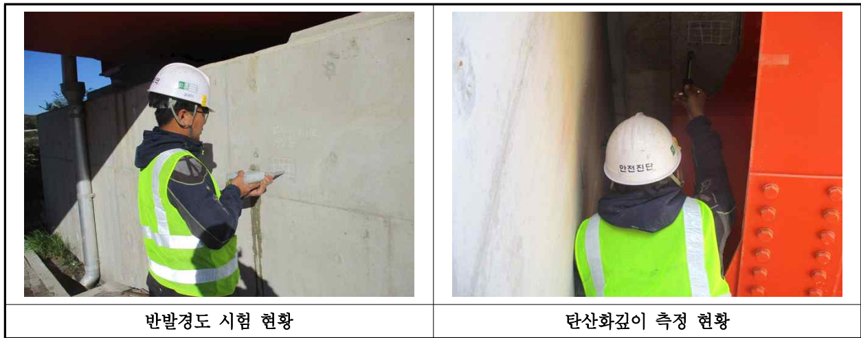
【사진 30.4.1】 콘크리트 내구성조사 현황
