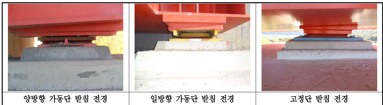
【사진 30.3.12】 교량받침 전경
