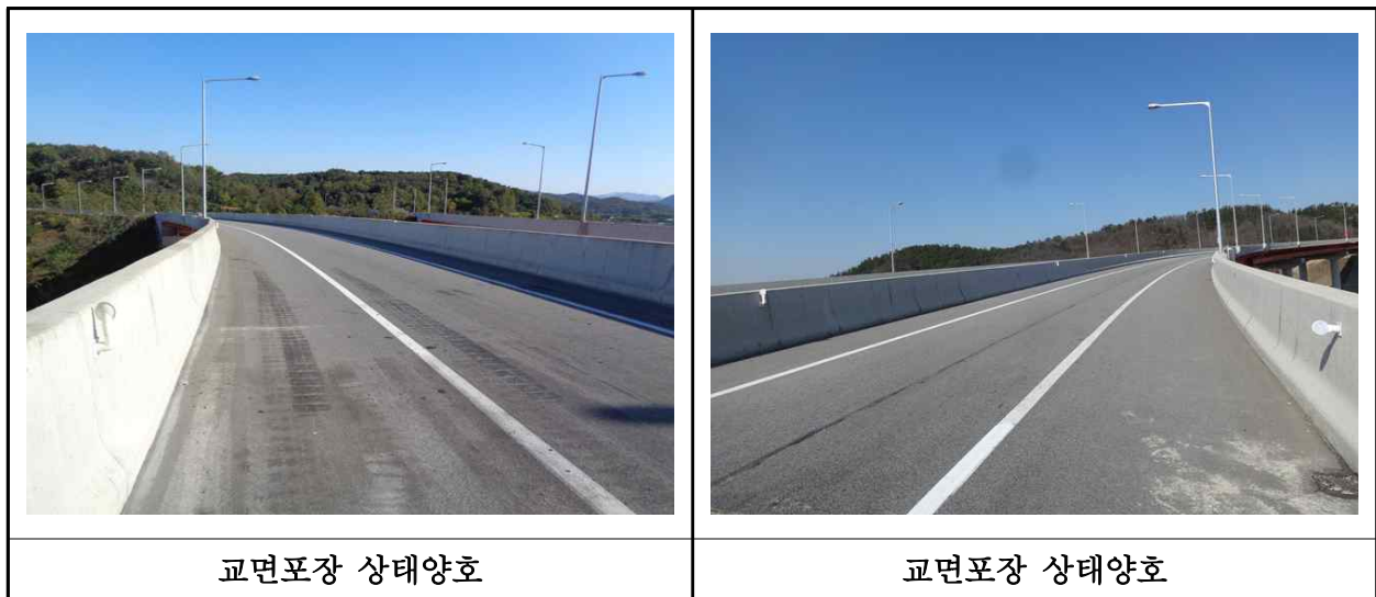
【사진 30.3.20】 교면포장 손상현황
